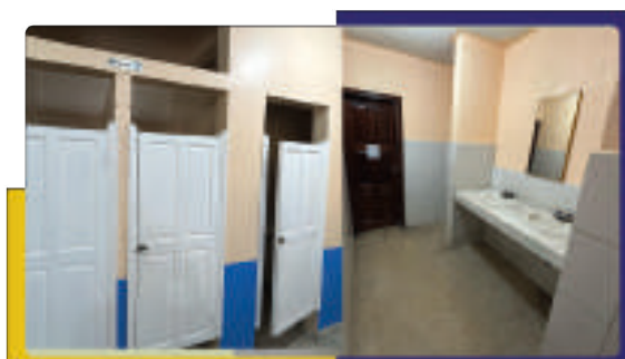
Mejoras en baños primer y segundo piso edificio B. tercer y cuarto piso edificio A
