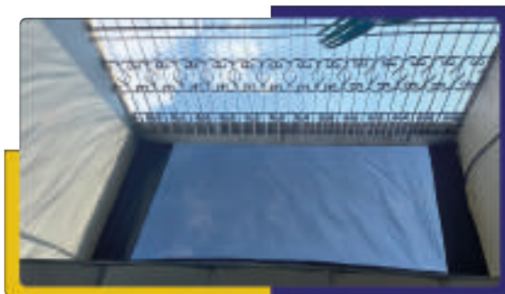
Sellado con sarán tragaluz del ala izquierda en escaleras central y escalera del fondo del edificio por escenario.
