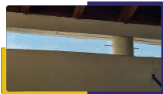
Vista detallada de como quedó el área sellada
